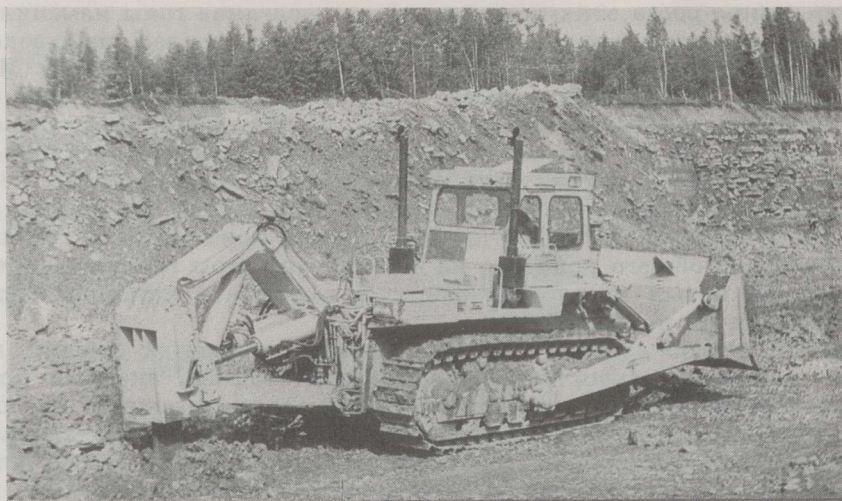
Рис. 3. Бульдозер-рыхлитель Д3129ХЛ в работе на разрезе «Вивиконд»
